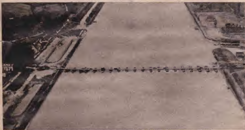
Das ist die Pontonbrücke über den Rhein zwischen Alt- und Neu-Breisach, die unsere Pioniere, anfangs im feindlichen Feuer, geschlagen haben
